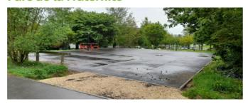
Discipline olympique depuis 2020, les Toulois pourront désormais s'en donner à cœur joie! Pour la réalisation d'une plateforme en enrobé qui accueille un terrain de basket 3/3, à côté des agrès urbains, terrassement, remblaiement, enrochement, pose de bordures, réglage de la forme et pose du panier de basket ont été réalisés par les agents du service voirie de la ville.
